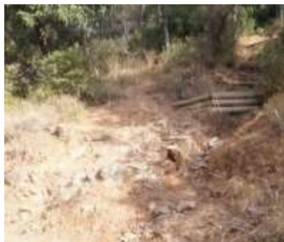
Aterrossament de talussos amb fustes.
