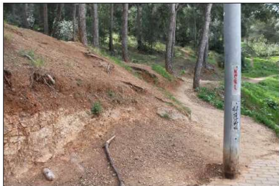
1 Talús a tractar amb mur de gabions
