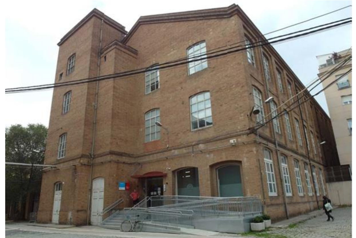
4. Façana posterior de la nau, a l'interior del recinte de la fàbrica Fabra i Coats.
