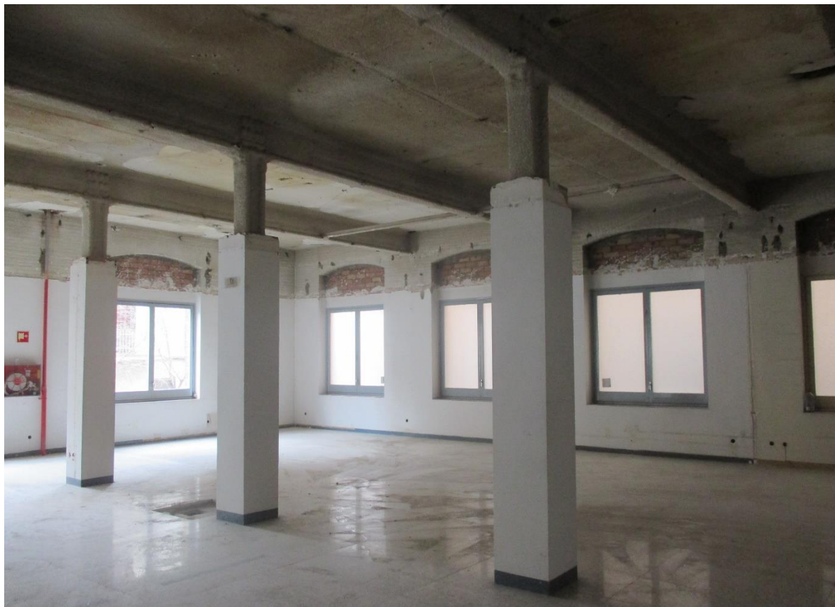
15. Interior de la planta primer pis, mirant a la cantonada nord-oest.
