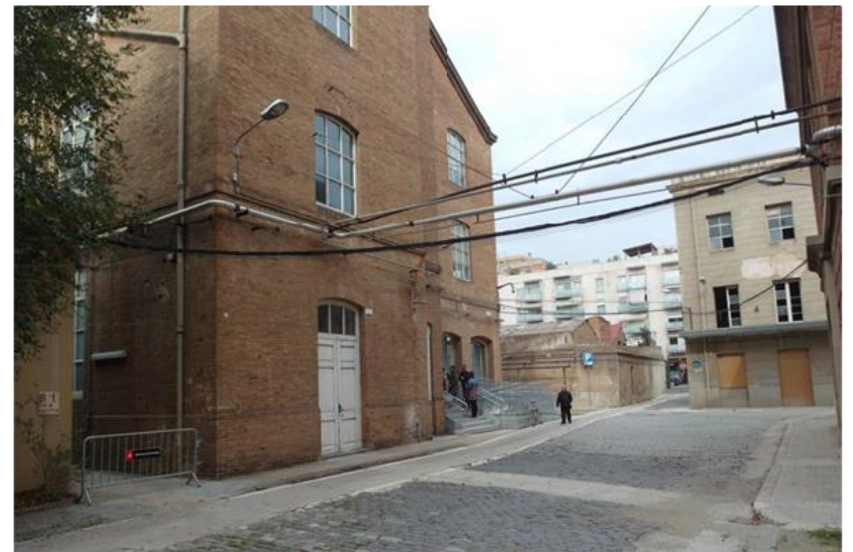
5. Façana posterior de la nau, a l'interior del recinte de la fàbrica Fabra i Coats.
