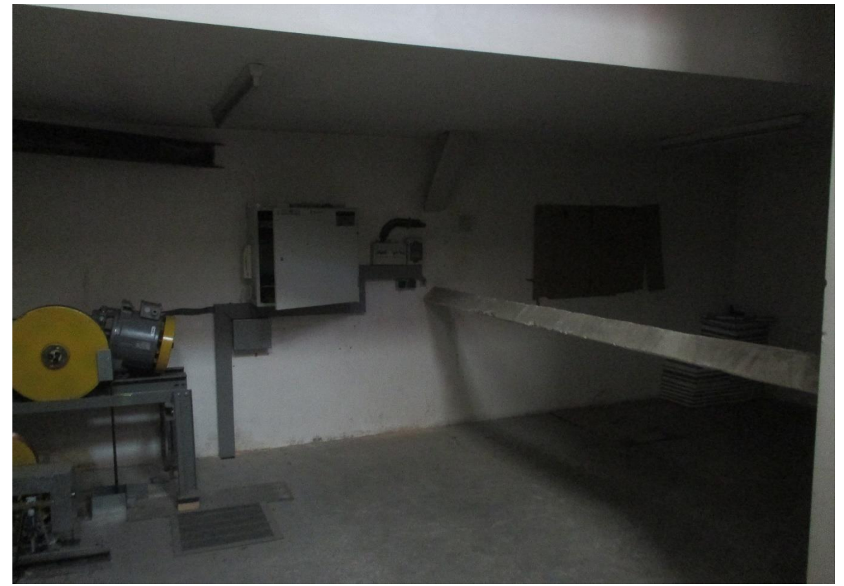
17. Interior de la planta altell, sota coberta.
