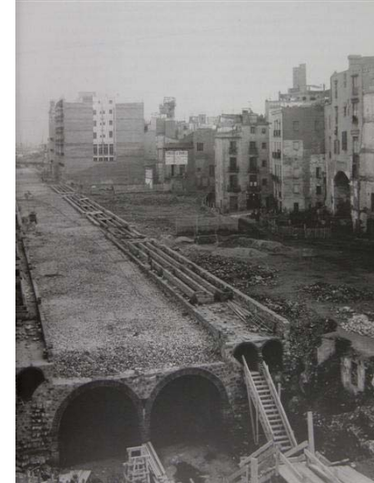
Finalització tram inferior túnels i galeries
