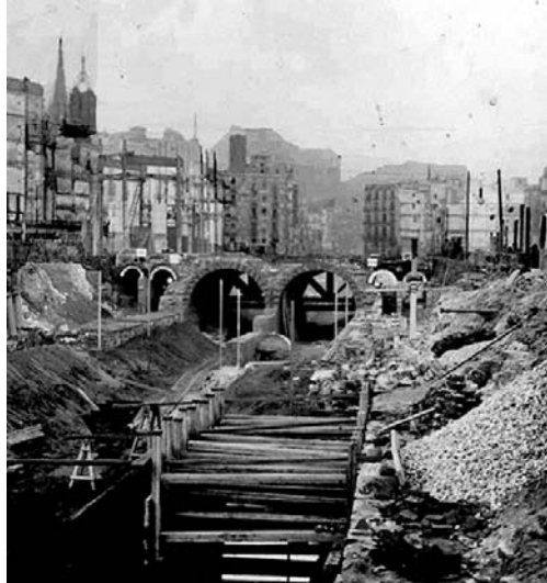
Construcció dels túnels i les galeries de serveis
