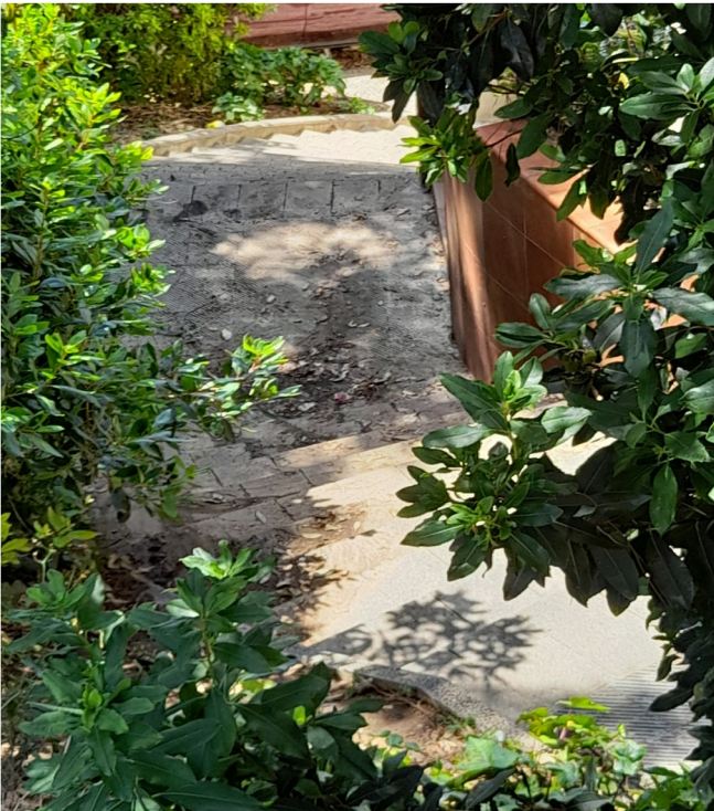
Escales Entre Montserrat Casanovas i Font de la Mulassa (Foto 6 i 7)
