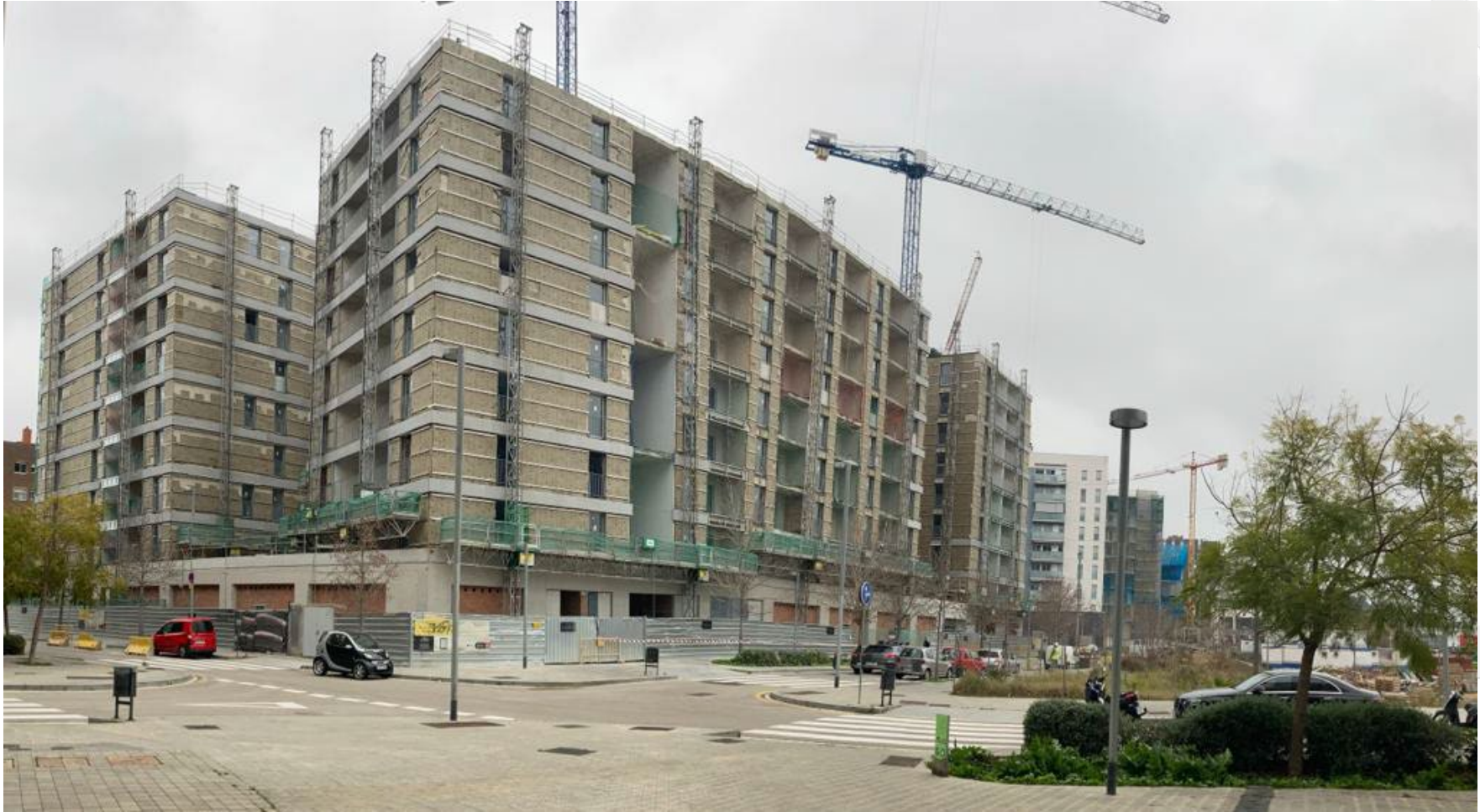
Foto estat Actual Obra
