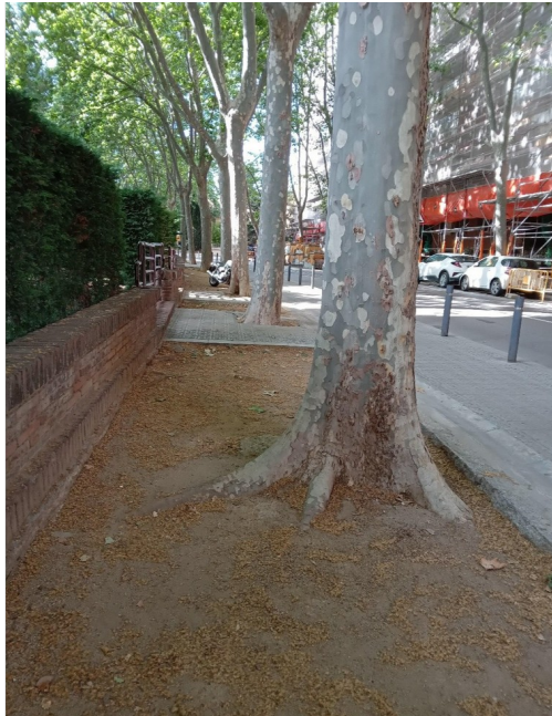
Escocell continu del carrer Marqués de Mulhacén (Foto 5)
