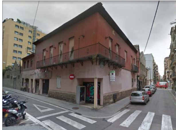
Estat actual de l'edificació.
