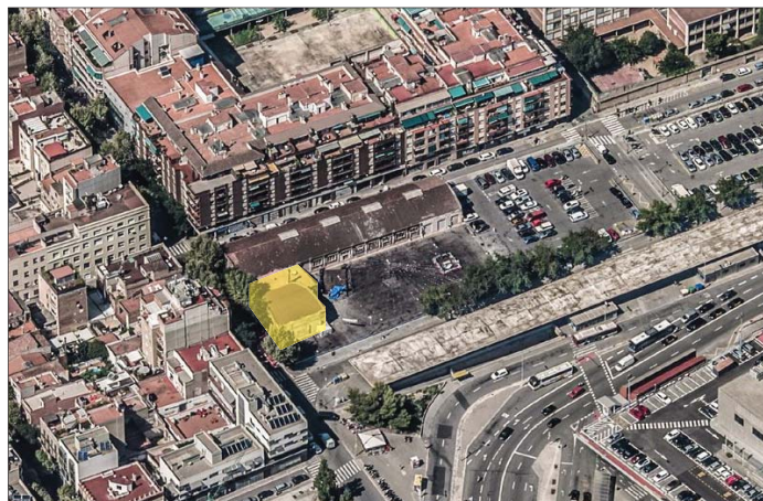
Vista aèria de la nau al c. Comtes de Bell-Iloc.
