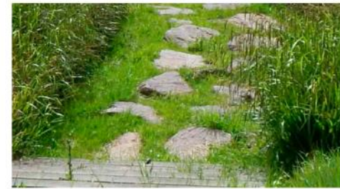
Recondicionament SUDS existents amb cobertura vegetal i plantació d'arbustives aptes per medi humit
