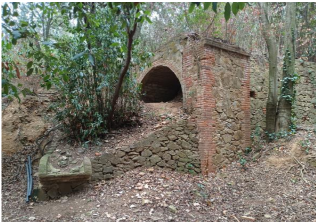
Murs i estructures zona antic pont
