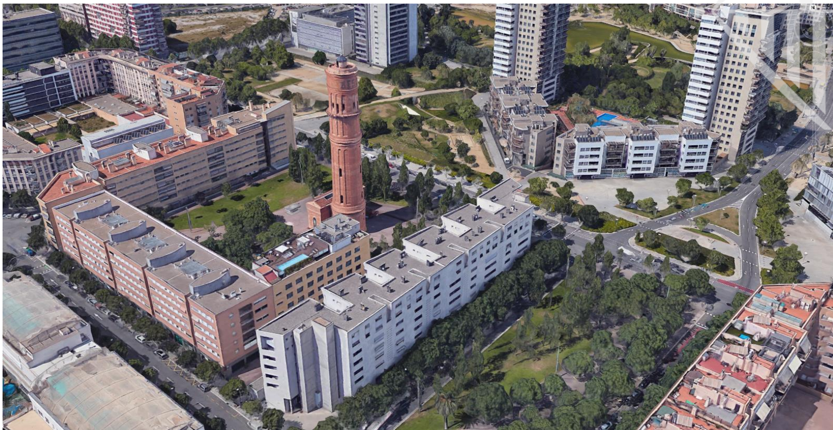
Perspectiva del conjunt de la Torre de les Aigües del Besòs i la Casa de les Vàlvules
