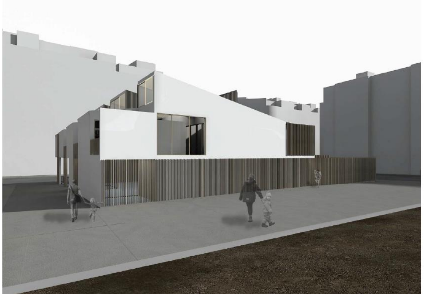
V06- VISTA _ accés Escola Bressol
