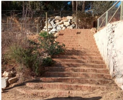
FOTOGRAFIA 4 ESCALERA DE LA ANTIGA FINCA BONAVISTA
