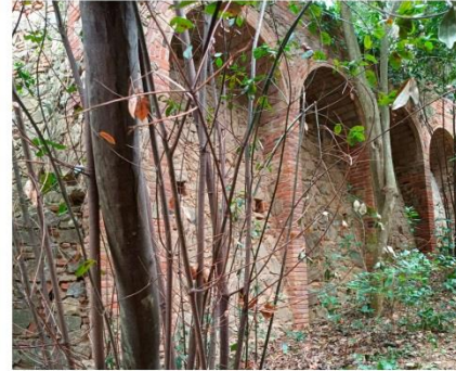
FOTOGRAFIA 21 AQUEDUCTE PERTANYENT A LA FINCA DEL CASTELL DE L'ORENETA
