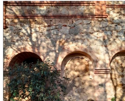
FOTOGRAFIA 6 MURO DE CONTENCIÓ DEL TERRENO, PERTANYENT AL CAMÍ PATRIMONIAL DEL CASTELL
