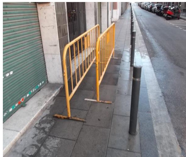
Estat després de l'actuació
