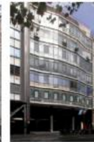
0027 Edifici comercial Mallorca
