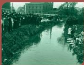
Inauguració de les obres de desviament del Rec Comtal (1916).
