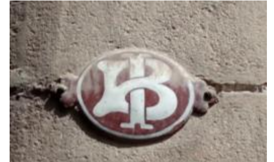
Senyalització boques d'incendi
