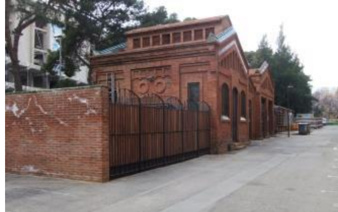
Pavelló Dipòsit Carbó, ara Auxiliar
