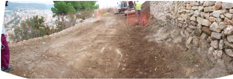
Imatges del procés d'obres
