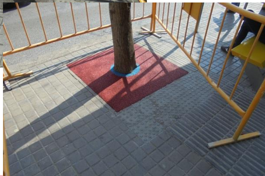
Estat després de l'actuació
