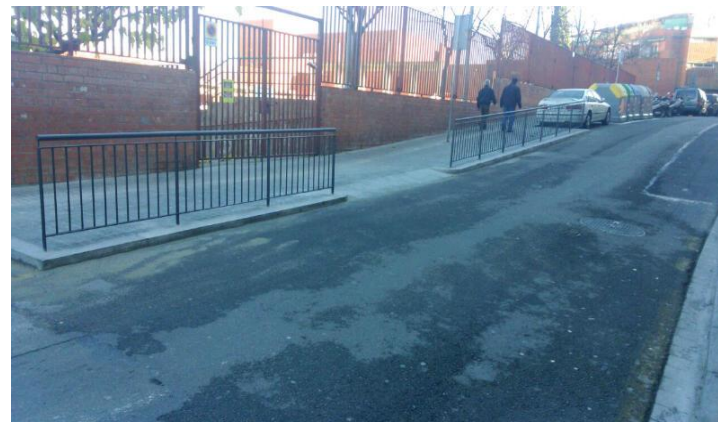
Estat després de l'actuació
