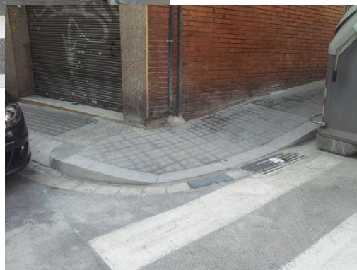
Estat després de l'actuació
