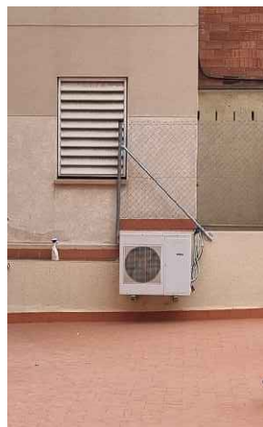
3_PROTEGIR INSTAL·LACIONS AMB LAMES DE FUSTA
