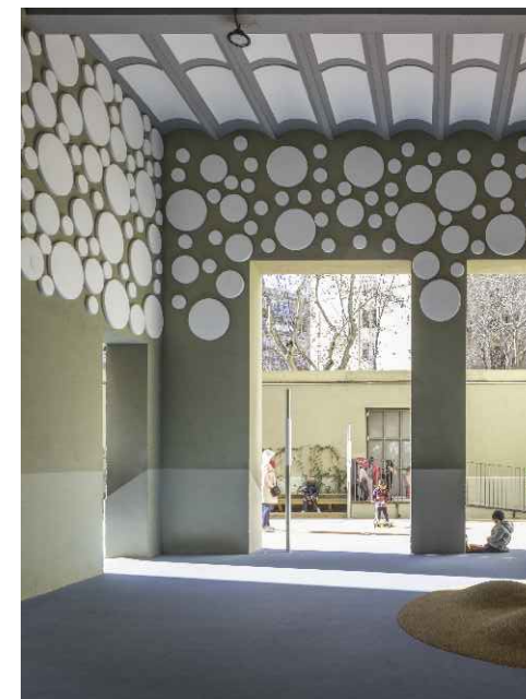
8_AÏLLAMENT ACÚSTIC DE RAMPA D'ACCÉS
