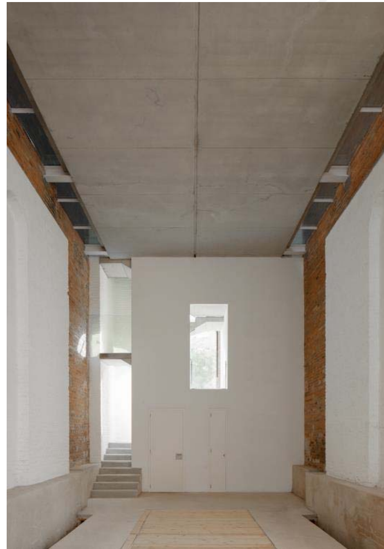
Casa de les Vàlvules Nivell 0
