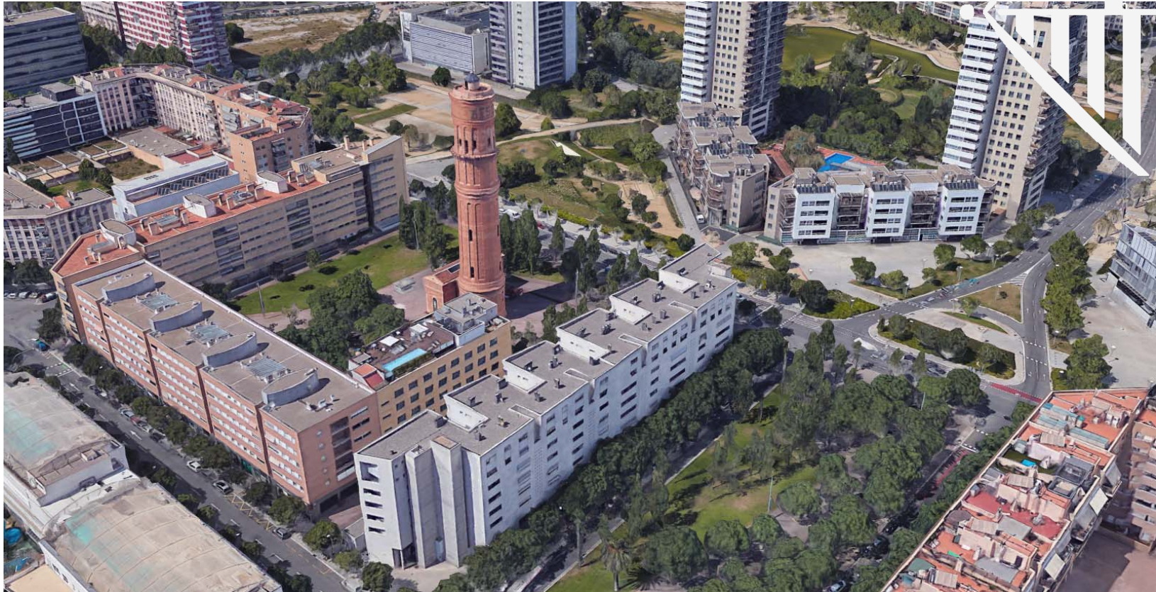
Perspectiva del conjunt de la Torre de les Aigües del Besòs i la Casa de les Vàlvules
