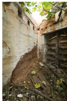
1. Desprelaments i disgregació dels murs de tàpia
