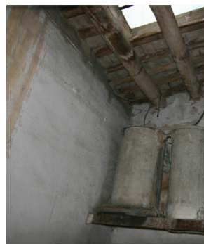
20. Humitats al badaiot de l'escala per filtracions de la coberta
