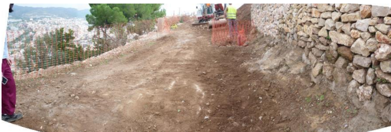
Imatges del procés d'obres
