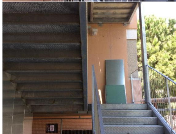
Estat de les obres a 17 d'abril de 2015
