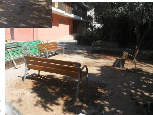
Estat després de l'actuació
