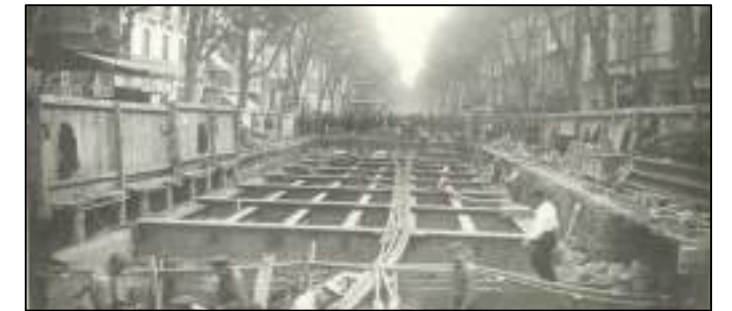
Treballs d'execució de la coberta del túnel de metro entre les estacions de Plaça Catalunya i Liceu
