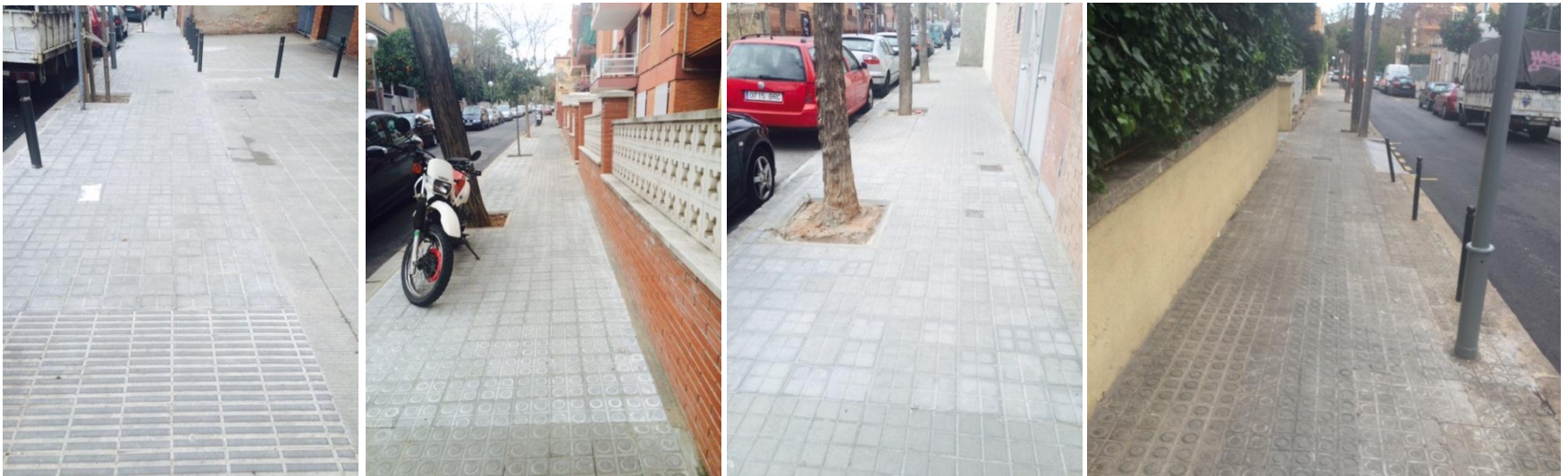
Estat després de l'actuació al carrer Hedilla (18/03/2015)
