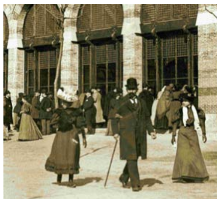
Entrada de la Casa dels Lleons
