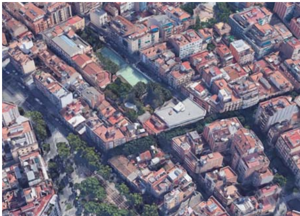
Edifici cantonada Rogent - Joan de Peguera
