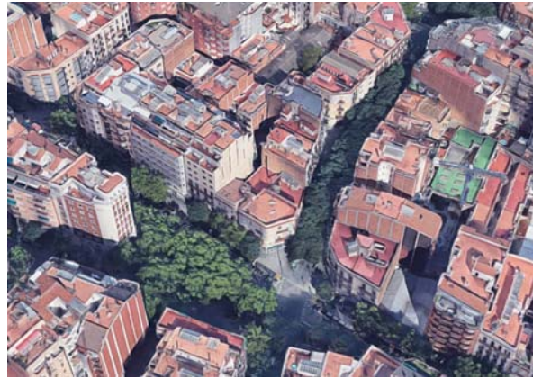
Afectació carrer Rogent - València
