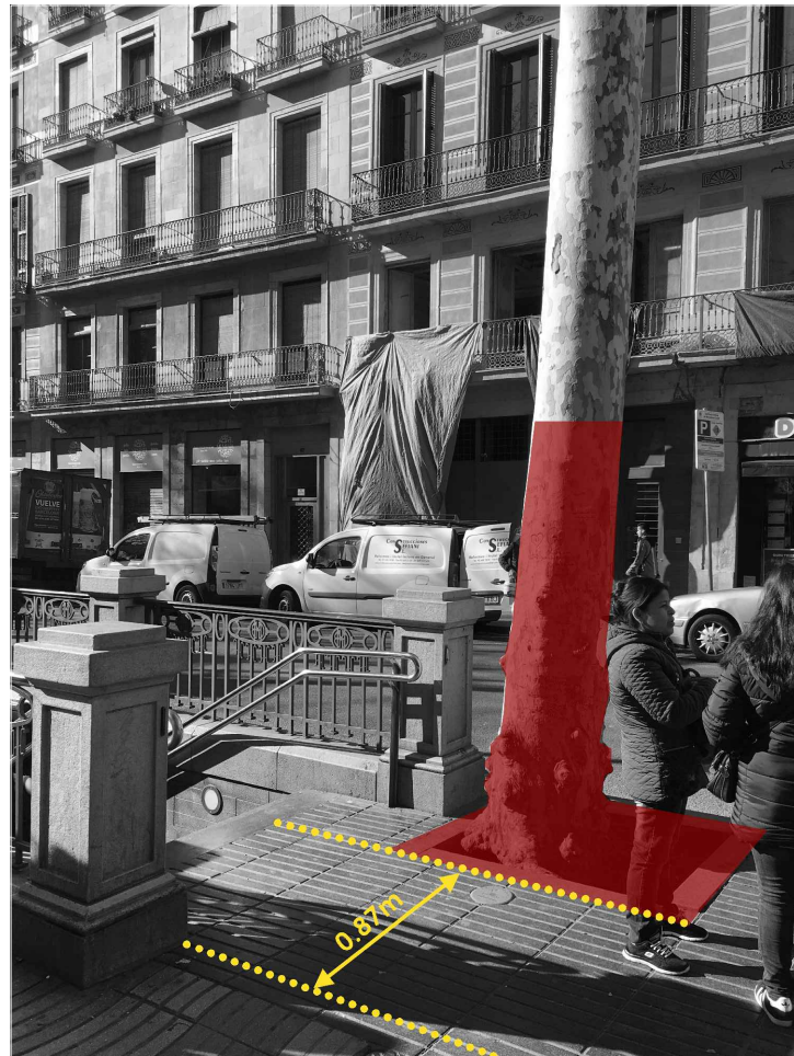
A6_Accés Metro Liceu (Problemes d'accessibilitat_accés metro)
