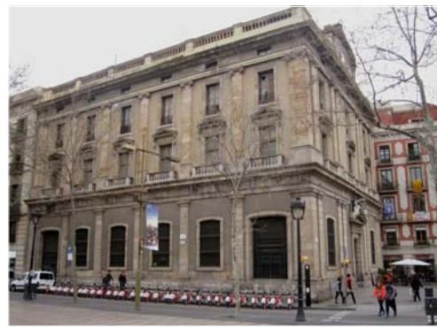
27B_ ANTIGA FONERIA DE CANONS (BCIN) any: final segle XVIII/1858 arquitecte: Josep Oriol Mestres Esplugas id. patrimoni: 454 la Rambla 2
