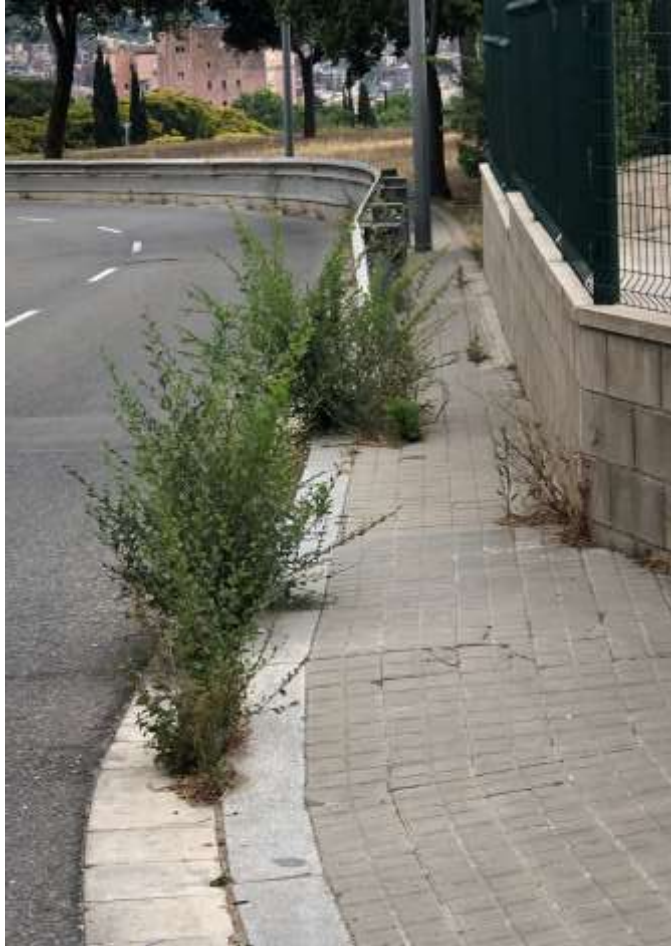
Camí de Cal Notari amb Cotxeres de TMB (Foto 29)
