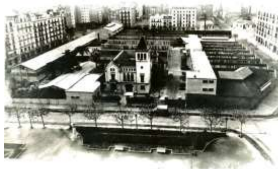
Fàbrica de motors Elizalde (Fundació Elizalde)
