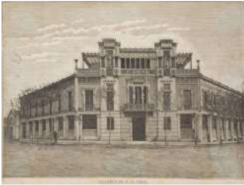
AHCB 12383, 1884, Gravats: Façana principal del taller de Francesc Vidal i Cia, situat al carrer Diputació amb Bailèn (obra de Josep Vilaseca) Gravats procedent de La Ilustración (Barcelona), IV, 177, 23 març 1884
