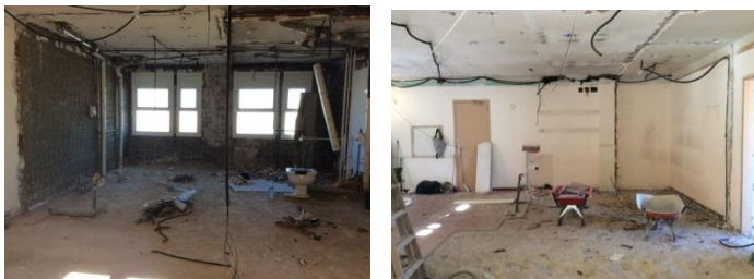
Execució de l'obra
