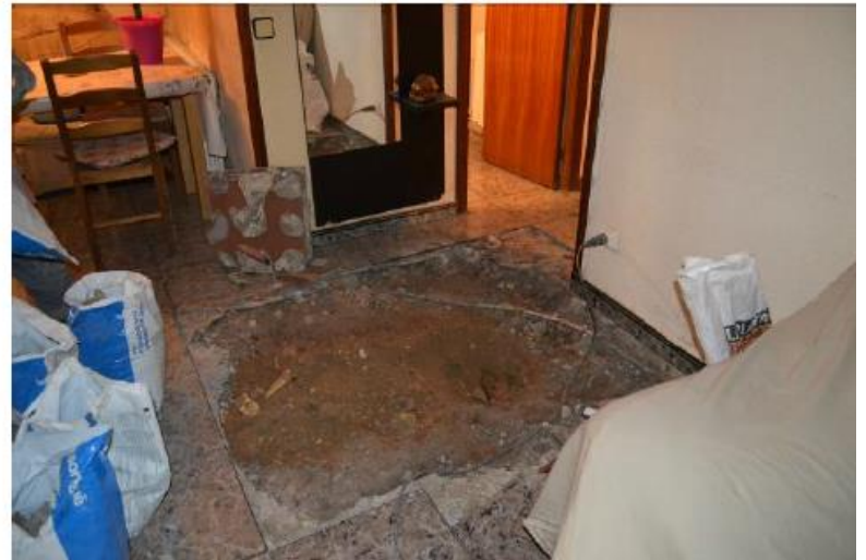
ARRELS QUE BOMBEN EL PAVIMENT
