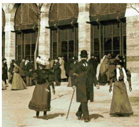
Entrada de la Casa dels Lleons
