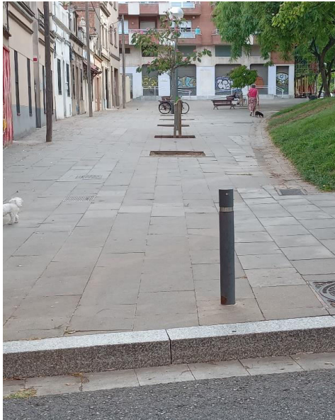
Carrer Pintor Tapiró 2 zona afectació (Foto 35)
