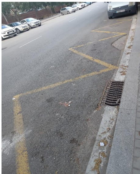
Carrer Pintor Ribalta, 5-7 (Foto 55)
