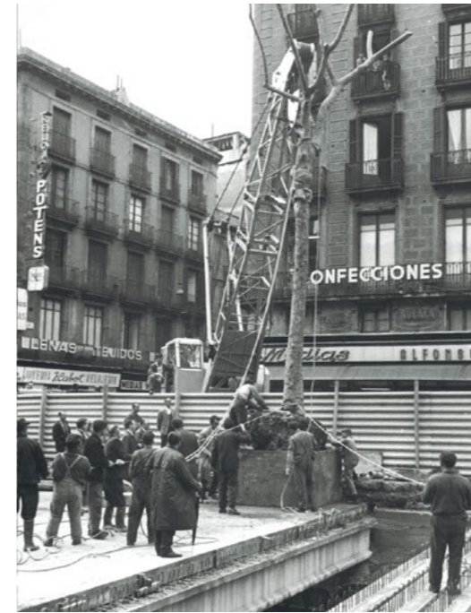
Obres del metro del Liceu. 1968
