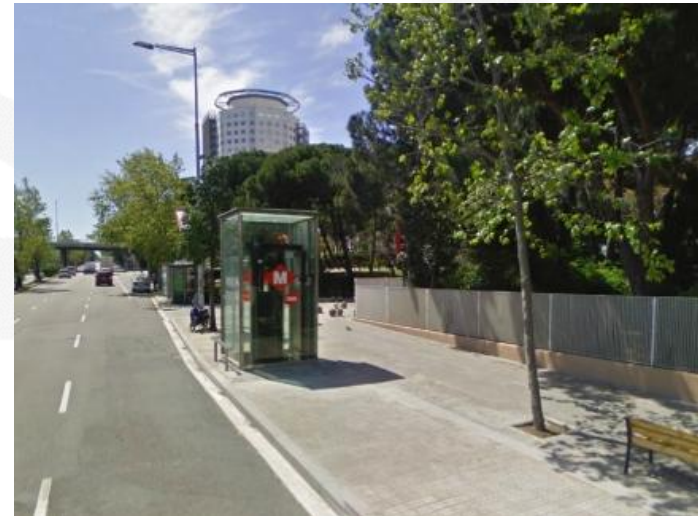
Ascensor per l'accés a l'estació de Montbau pel passeig de la Vall d'Hebron (L3).
