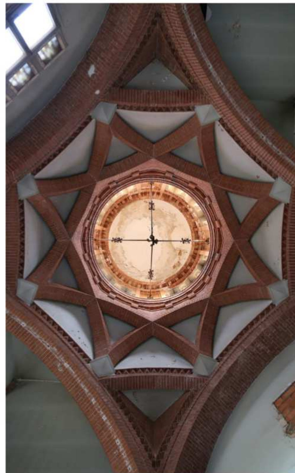
Estructura del lluernari i cupulí de la Sala d'actes.
