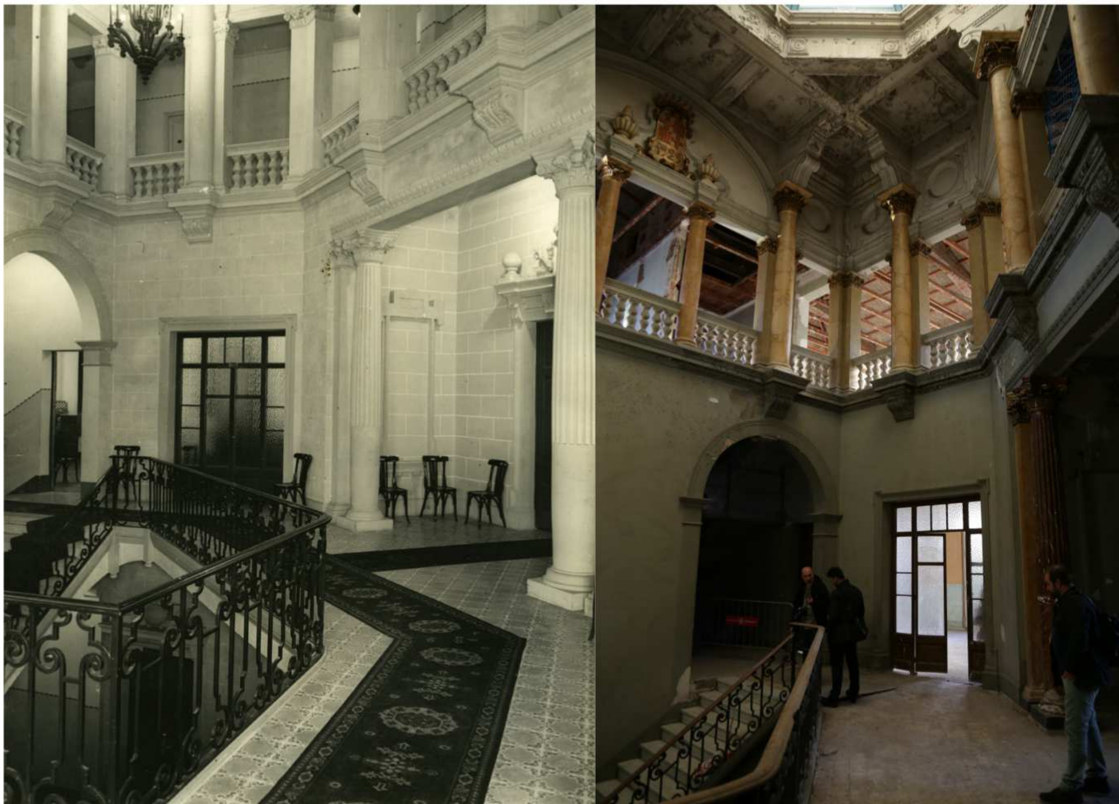
Contrast cromàtic: l'edifici original tenia un aspecte sensiblement distint: la pintura, de tons molt clars, simulava un aparell de carreuat regular que el repintat va fer desaparèixer. A la vegada ni els fusts ni els capitells ni altres elements de les columnes estaven pintats. Altres fotografies antigues permeten constatar que els escuts de la ciutat tampoc estaven pintats. La contenció cromàtica de la proposta original atenua de manera notable el pes de l'aparell decoratiu, limitant l'efecte de sobrecàrrega v
