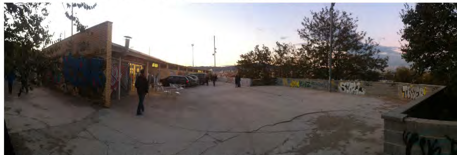
Visat de l'explanada a la cota +52,50 amb l'edifici dels vestidors a l'esquerra. Al fons l'arribada de la rampa d'accés.
