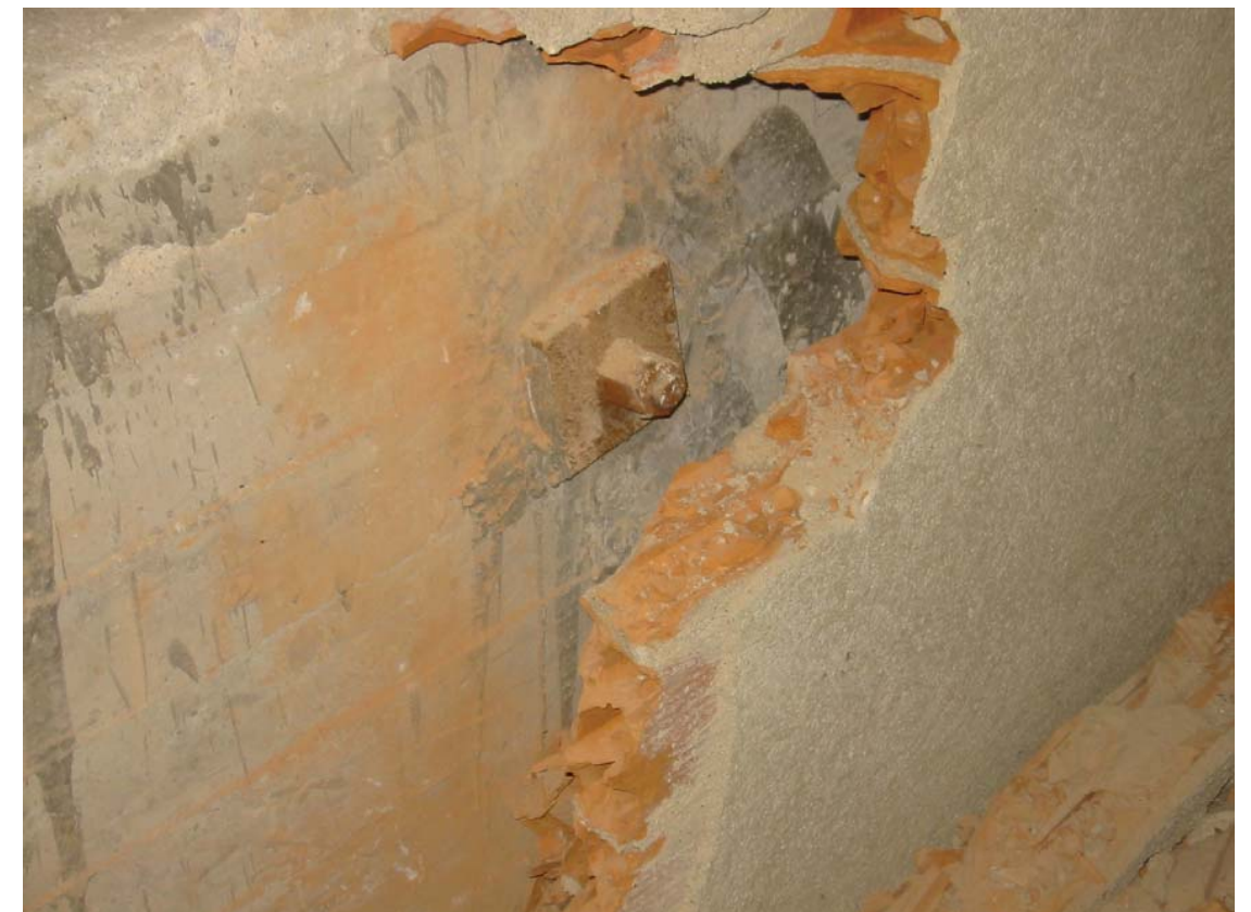
Fotografia 2- Connector mur de formigó pobre- reforma 1984
