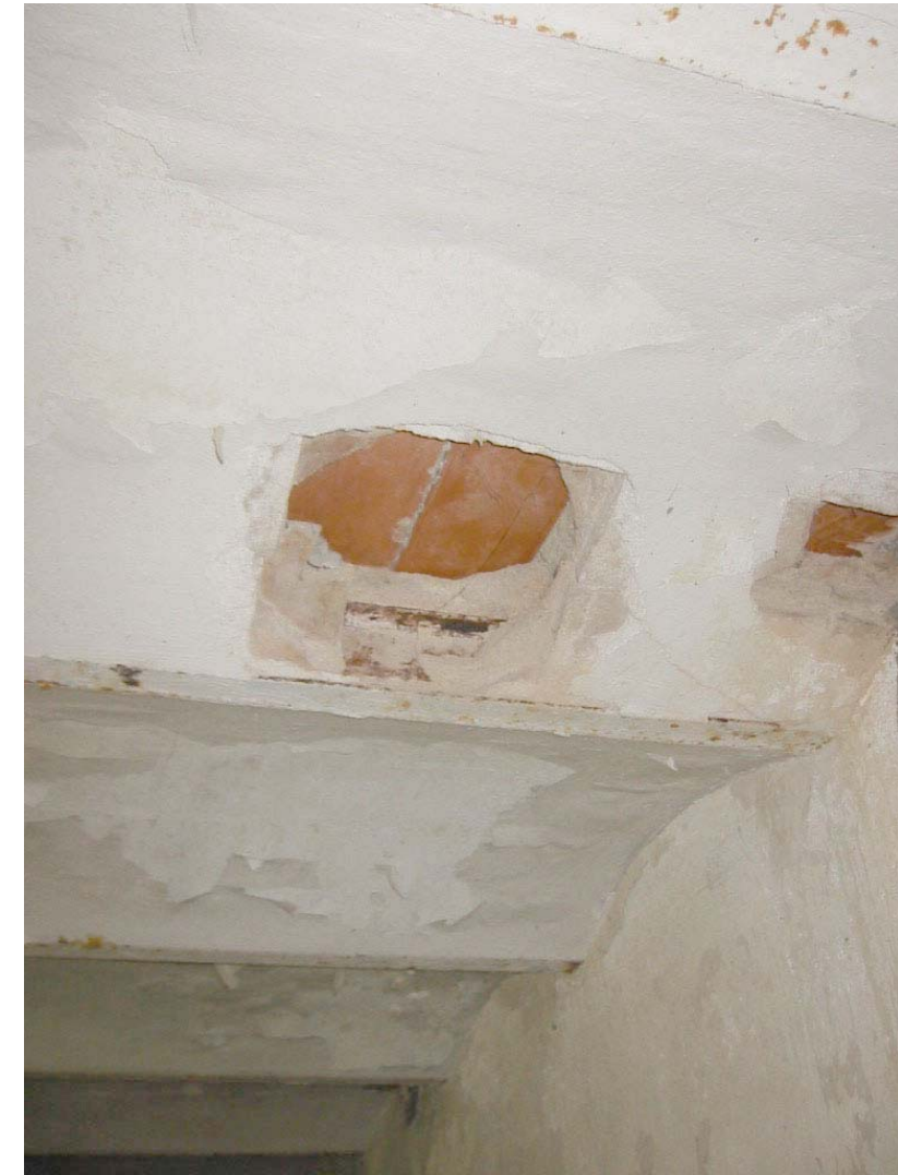
Fotografia 5- Forjat de biguetes metàl.lic
