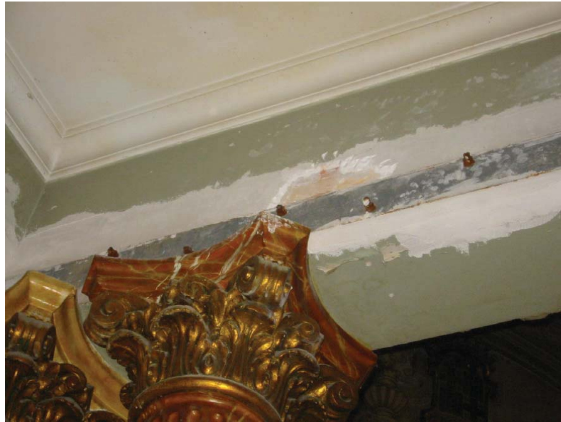
Fotografia 3- Encercòlament pati central-reforma 1984
