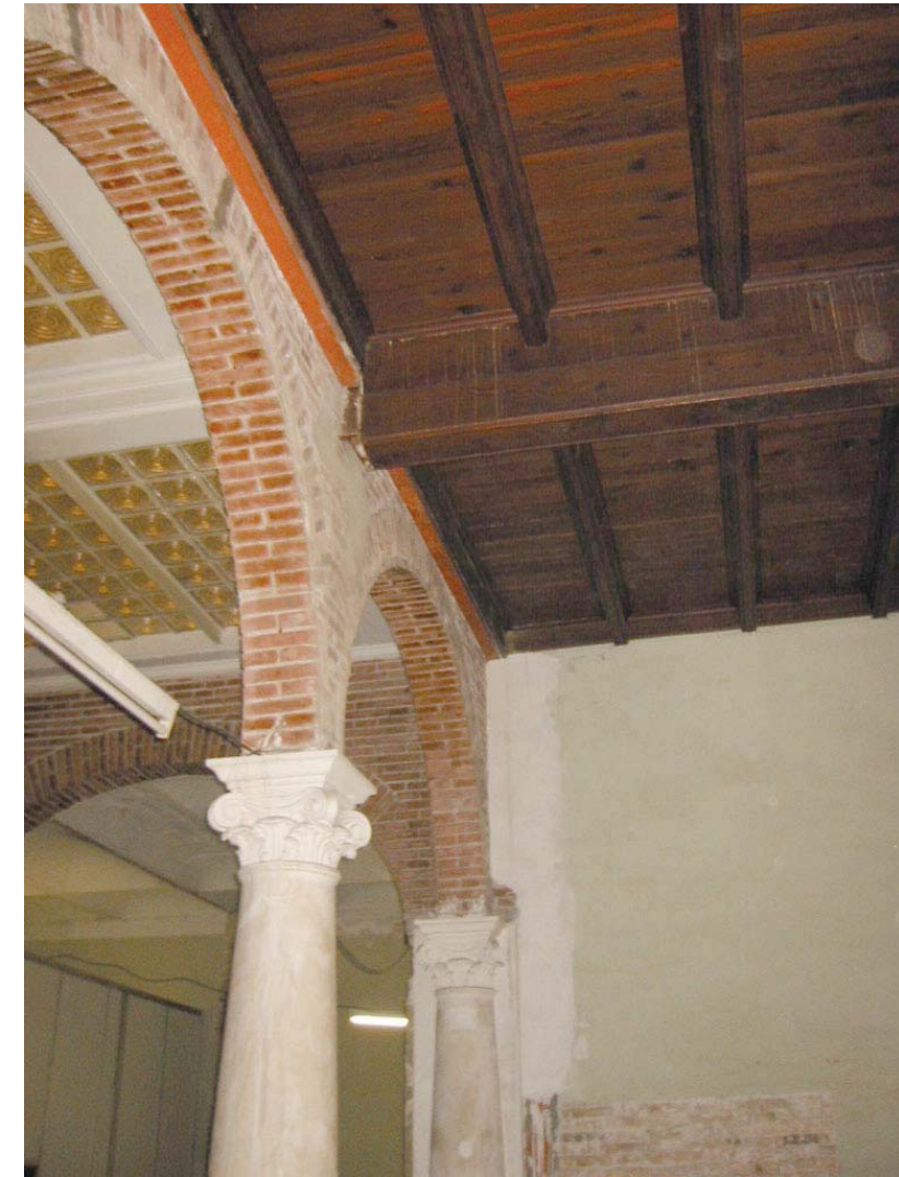
Fotografia 7- Forjat de biguetes de fusta amb bigues metàl.liques
