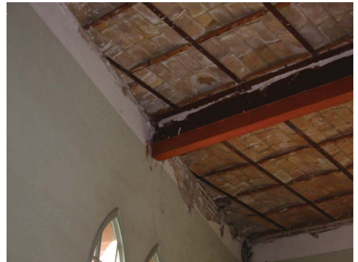
Fotografia 10- Forjat de biguetes de metàl.liques a reforçar sostre planta primera zona 2
