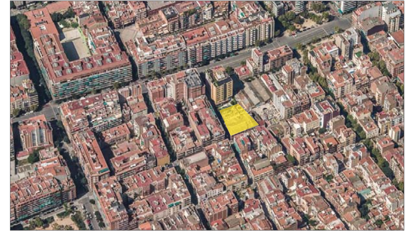
Vista aèria general de la integració de l'edifici en el teixit urbà de Sants.
