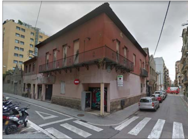
Estat actual de l'edificació.
