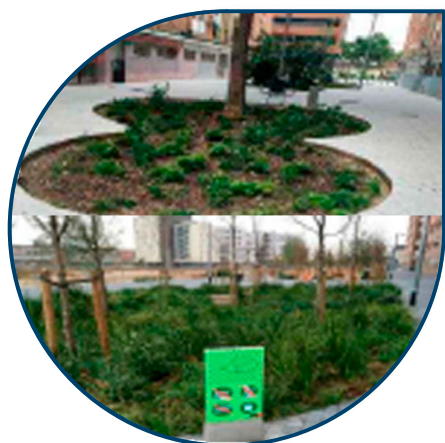
Exemple de SUDS amb vegetació Font: BCASA
