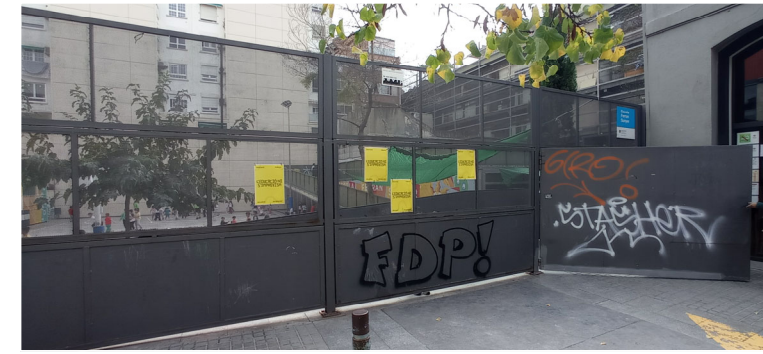
F1. ACCÉS EXISTENT ESCOLA. INTERFERÈNCIA TERRASSES BARS
