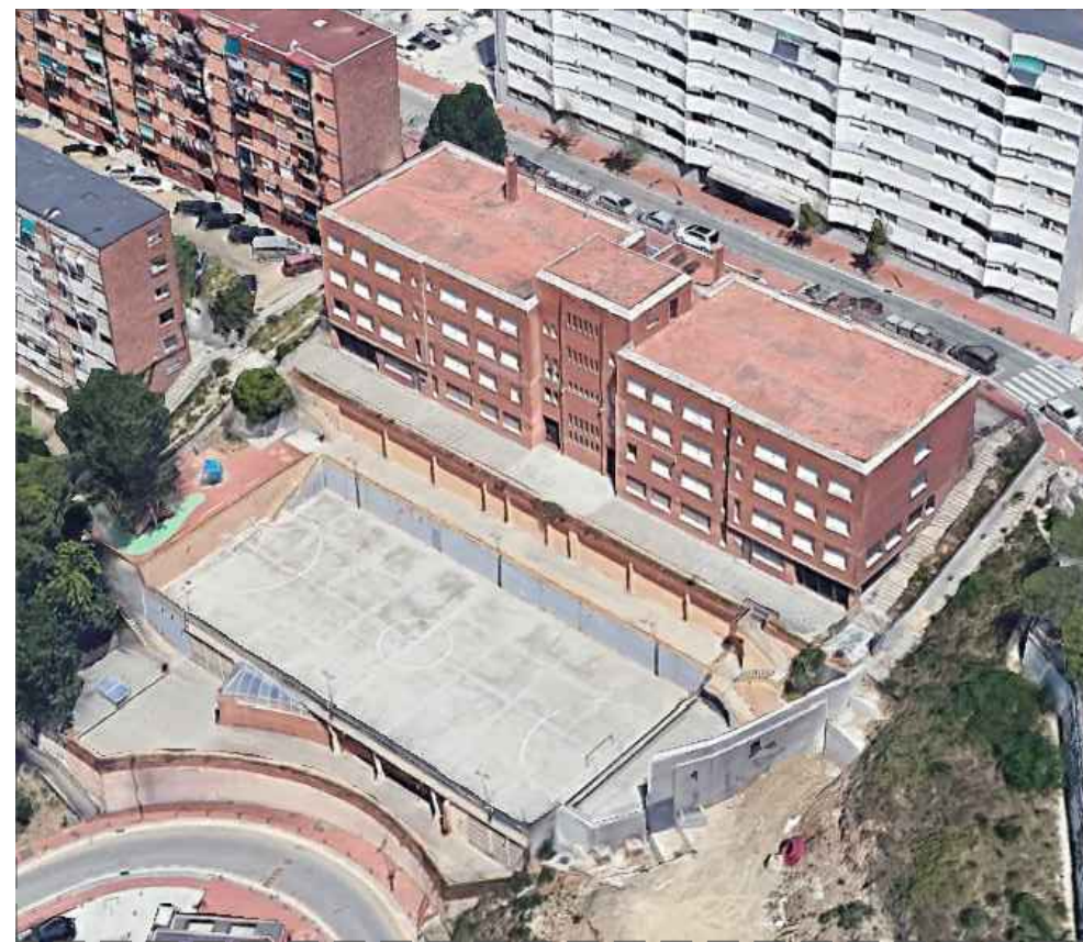
VISTA D'EDIFICI A INTERVENIR
