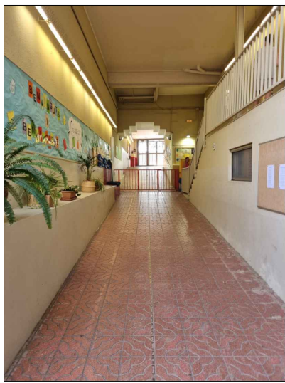
1_SUBSTITUCIÓ DE TERRATZO PER A PAVIMENT ANTILLISCANT DE LLOSA PREFABRICADA DE FORMIGÓ
