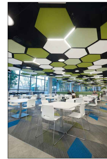
4_INSONORITZACIÓ AMB PANEL·LS HEXAGONALS FONOAORSORBENTS ADHERITS AL SOSTRE
